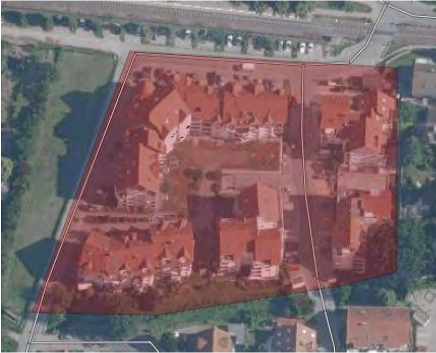
Abb. 17-11: Siedlungstyp 5b - Mittlere Mehrfamilienhäuser
